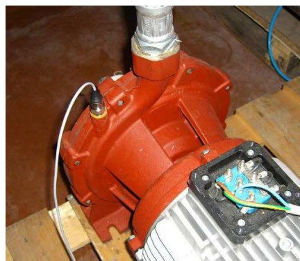
Figura 5: Montaggio trasduttore sul foro di riempimento di mandata
