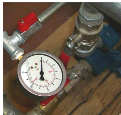
Figura 7: Sostituzione del manometro sulla mandata con il trasduttore di pressione
