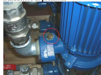
Figura 8: Montaggio del trasduttore nel foro di sfiato da 1/4"
